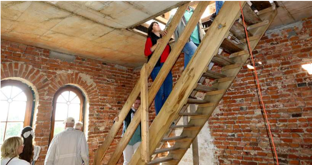
Vom Keller bis aufs Dach: Am Sonntag ist wieder ein Rundgang über und durch die Baustelle von Schloss Broock möglich. FOTO: STEFAN HOEFT
