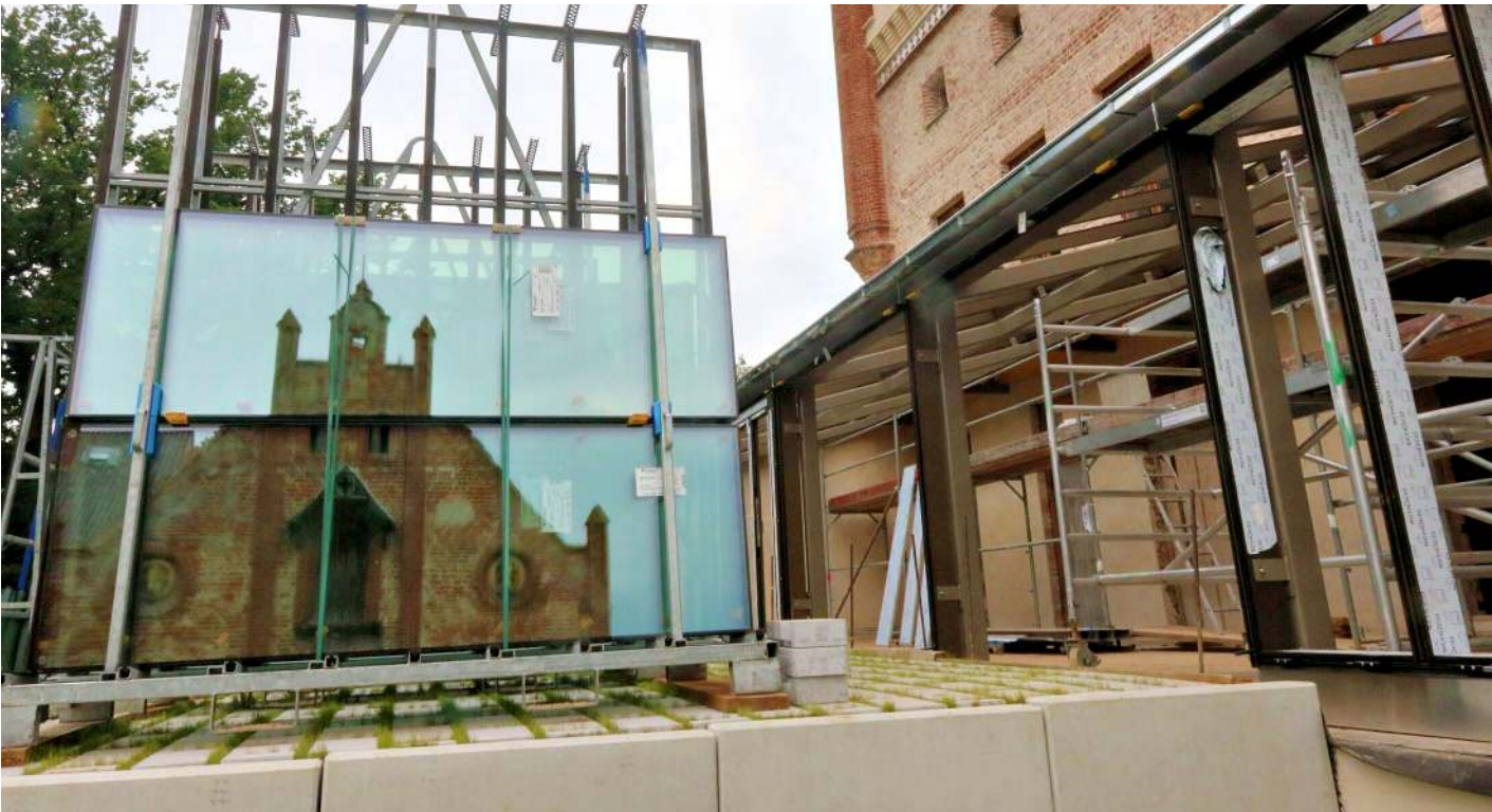
Im Spiegel der Zeit: An Schloss Broock stehen die Fensterscheiben bereit für den neuen Wintergarten am Südgiebel. Was es sonst noch neues dort gibt, lässt sich am Tag des offenen Denkmals am 14. September erfahren.
