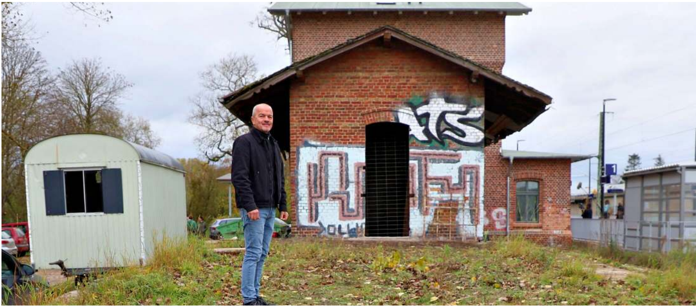
Der Bahnhof Sternfeld wird saniert. Am einstigen Empfangsgebäude sind die Gerüste bereits abgebaut, der frühere Güterschuppen ist noch eine Baustelle. Projektleiter Christian Schmidt auf der Rampe, die zu einer Freiluftterrasse werden soll.
