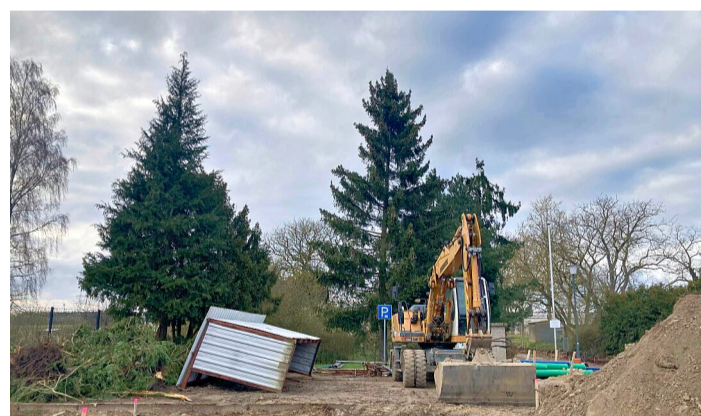
Ganz offensichtlich geht es auch an der alten Bushaltestellen-Einfahrt in Sassen baulich gerade voran. FOTO: ULRIKE ROSENSTÄDT
