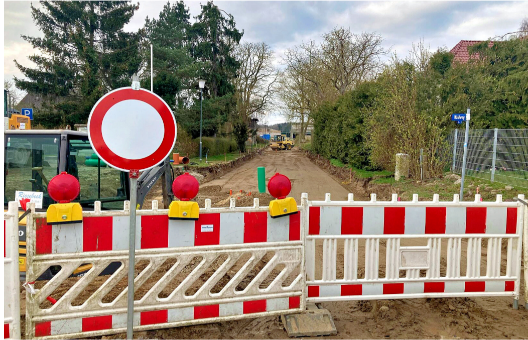
Aktuell wird mit Hochdruck am Straßenbauprojekt Waldweg in Sassen gearbeitet. Eines der größten Vorhaben, das die Gemeinde im Haushaltsjahr 2024 umsetzt. FOTO: ULRIKE ROSENSTÄDT
