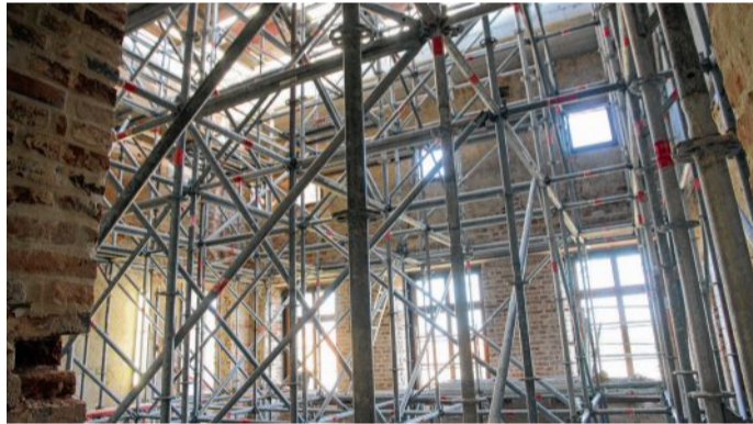
Ein Dickicht aus Metallstangen: Dieses komplexe Gerüst wurde im Innern hochgezogen, um das letzte Stück Decke zum Dachgeschoss hin betonieren zu können.
