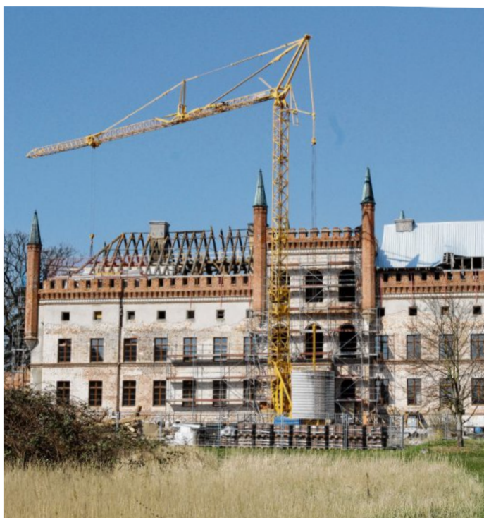
Von der Ruine zum neuen Veranstaltungs- und Beherbergungsort: Am Montag werden auch wieder Baustellenführungen durch Schloss Broock angeboten.
