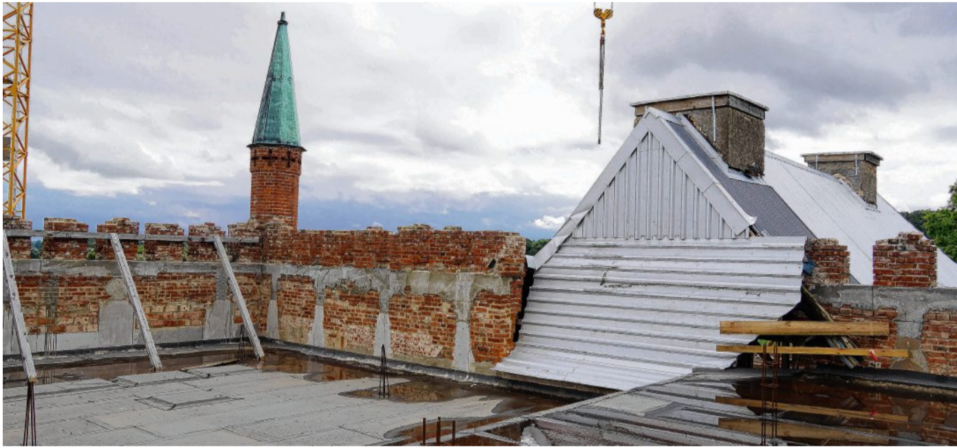
Der Baukran auf dem Schloss-Broock-Gelände dreht sich weiter. In Phase fünf der umfassenden Baumaßnahme wird der Dachstuhl im Südfügel repariert. Eingeschlossen ist dabei auch die Sicherung der Zinnen. Zudem werden Schornsteine aufgemauert.
