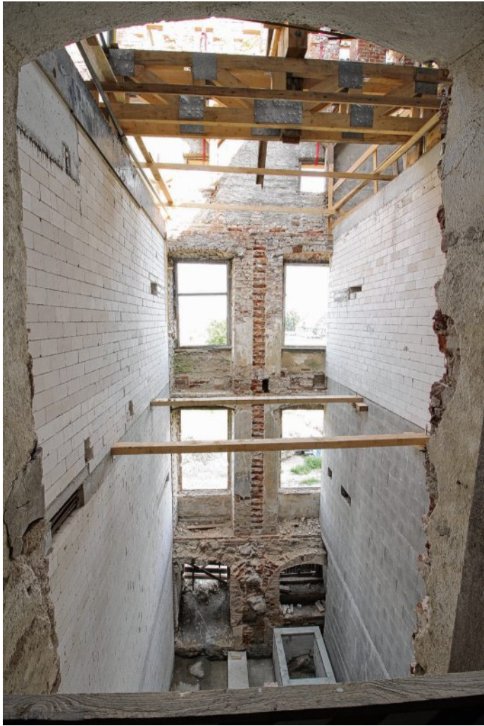
Noch ohne Innenleben: Das neu gemauerte Treppenhaus für den Nordflügel des Broocker Schlosses wirkte schon in diesem Zustand majestätisch hoch.
