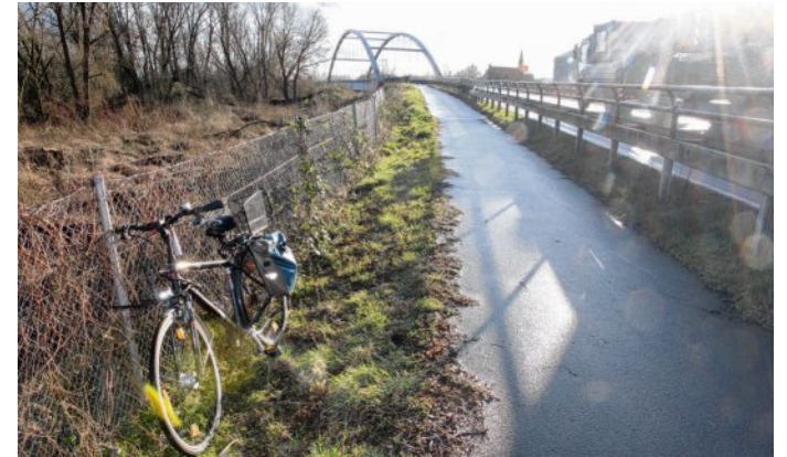
Der Ort des Geschehens im Februar 2020: Von der nahen Landesstraße aus war wegen der Schutzkonstruktionen damals nur das Fahrrad des alten Mannes zu sehen. Doch Manja Reisener hielt an und schaute glücklicherweise über die Barriere. FOTO: STEFAN HOEFT
