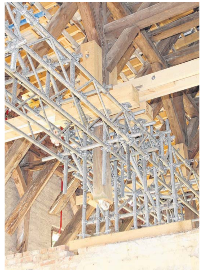
Fast scheint es, als würde der altherwürdige Dachstuhl losgelöst von Schloss Broock in der Luft schweben. Denn momentan halten ihn vor allem Hilfskonstruktionen.
