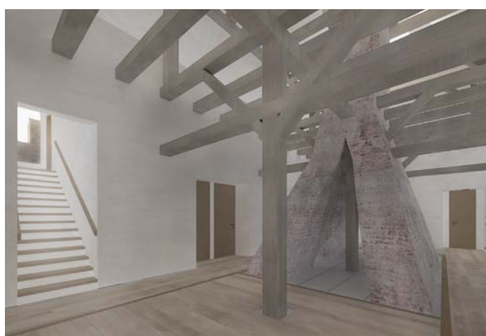
Eine Art Maisonette-Lösung: Für das Dachgeschoss der Seitenflügel wurde eine neue offene Bauweise konzipiert, die den alten Dachstuhl erlebbar lassen.
