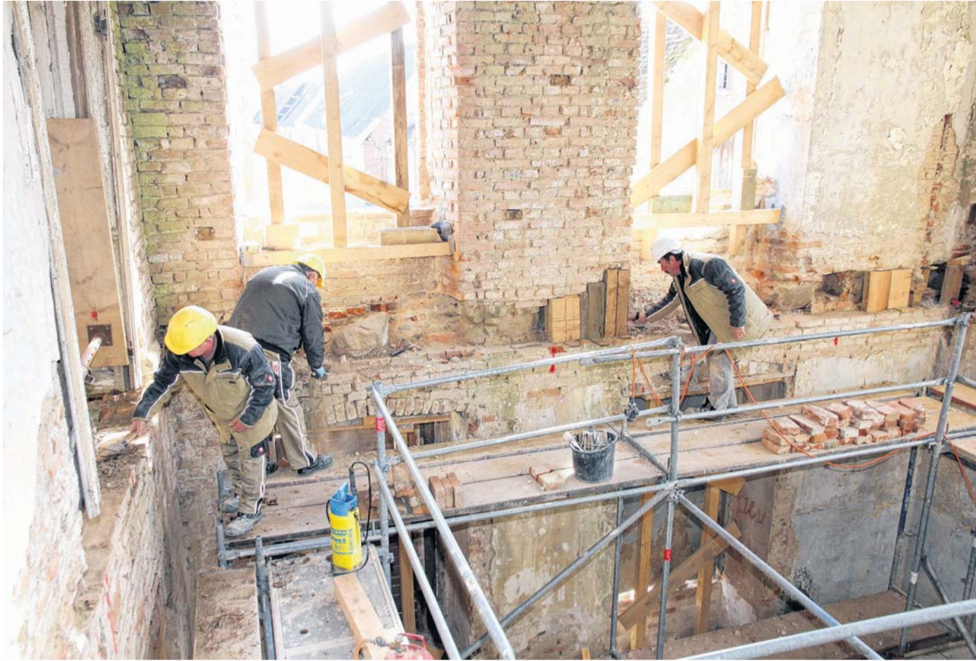
Mammut-Projekt Schloss Broock: Handwerker befreien hier das Mauerwerk von alten Holzresten, bevor es an das Einziehen der nächsten Geschossdecke geht. FOTOS: STEFAN HOEFFT
