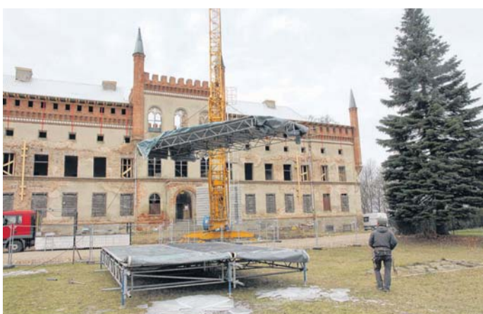
Während die Blechprofilplatten über den Seitenflügeln noch im alten Jahr Stück für Stück montiert wurden, hievte der Kran das Notdach für den Mitteltrakt in ganzen Segmenten nach oben.
