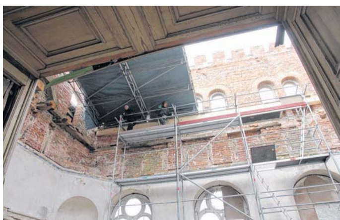
Mangels Balken im Mittelrisalit mussten die Gerüstbauer Hilfskonstruktionen und provisorische Auflagen für das Notdach schaffen.
