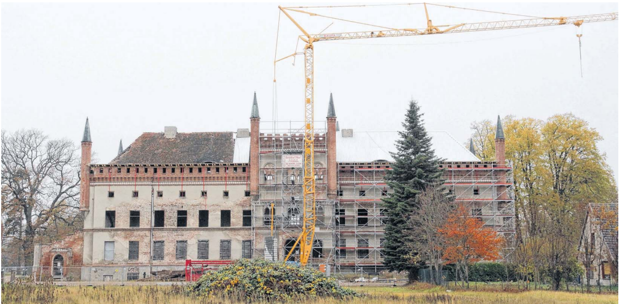
Über dem Nordflügel ist das Notdach bereits so gut wie fertig, Ende November/Anfang Dezember soll auch der Südflügel von oben dicht sein.
