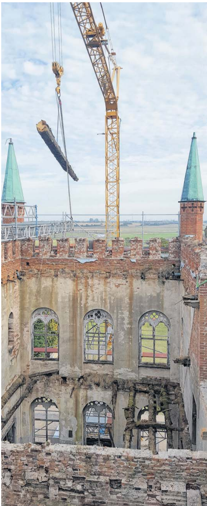
Freier Blick und Fall von oben bis unten: Halt gaben sie ohnehin nicht mehr, deshalb wurden die letzten verbliebenen Balken im Mittelrisalit mit Hilfe von Kran und Kletterern heraus gehievt.
