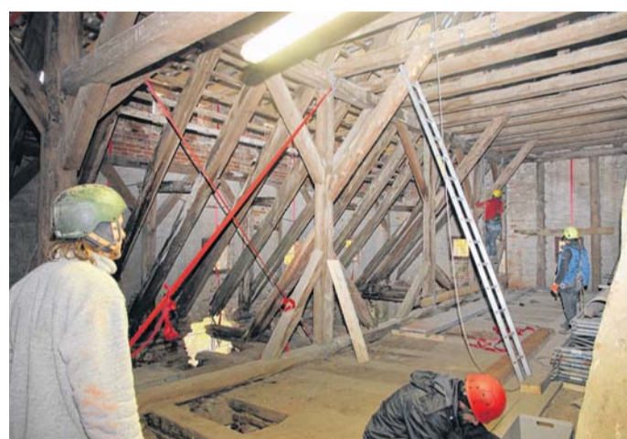
Mit zahlreichen langen Spanngurten durch Gebälk und Mauerwerk wird die Konstruktion provisorisch stabilisiert.
