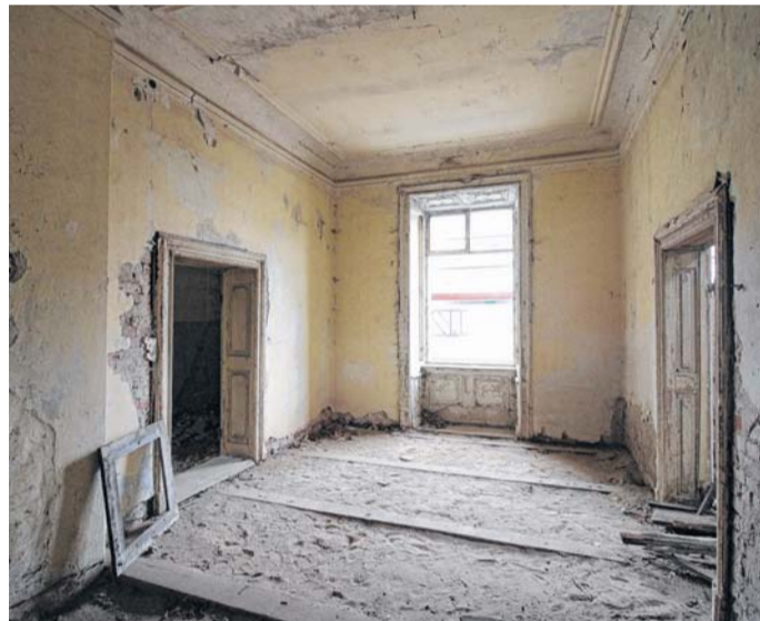
Bodenloses Raritäten-Kabinetts mit Decke: Dieser kleine Salon am Nordgiebel des Hochparterres weist noch bauzeitliche Denkmalsubstanz auf, die während des großen Stüler-Umbaus (1841-1843) nicht überformt wurde.
