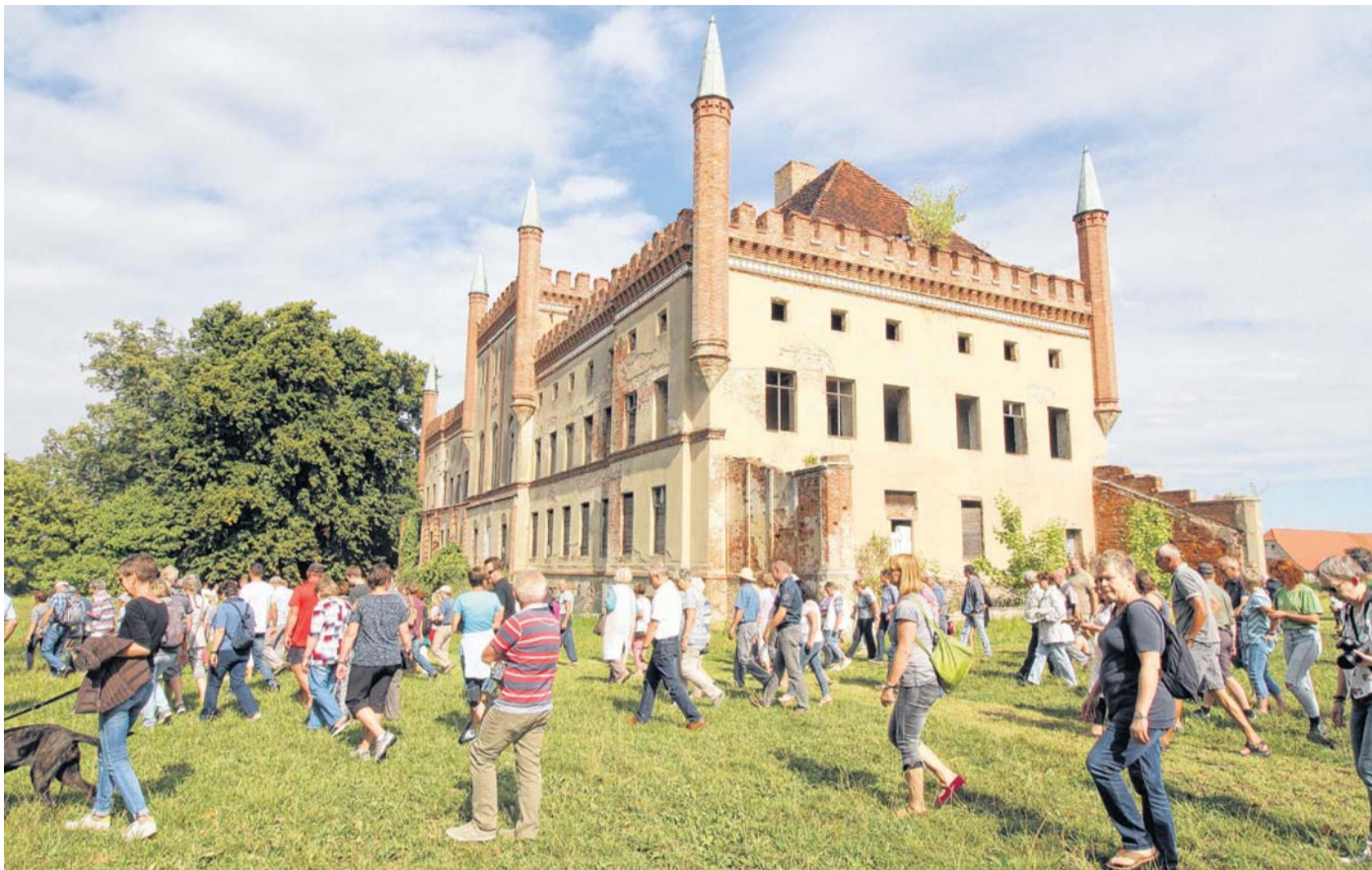
Bel(i)ebte Ruine: Zum Tag des offenen Denkmals vor einer Woche war die Schlossanlage Broock wieder von Hunderten Besuchern bevölkert. Ab Oktober sollen hier Bauarbeiter für Wirbeln sorgen, denn dann startet die Notsicherung. FOTOS: STEFAN HOEFT
