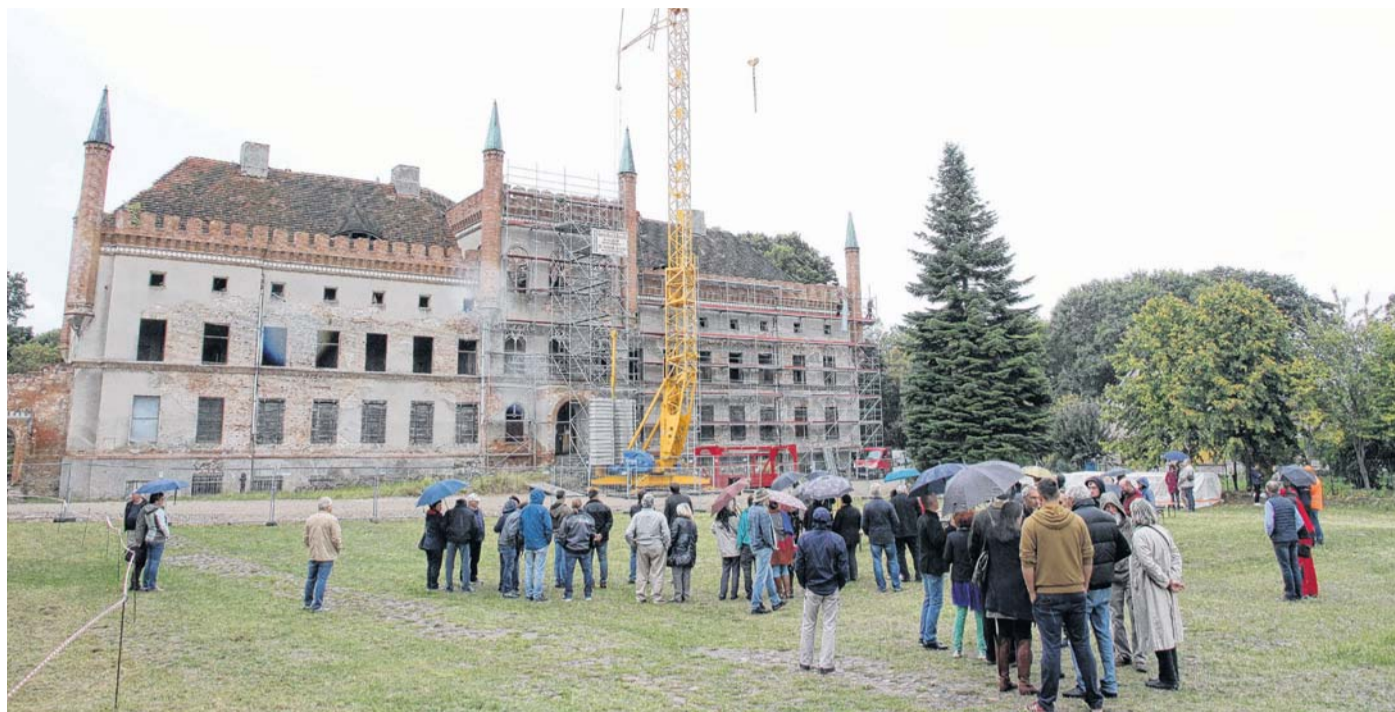
Der Baukran an der Vorderfront steht, das Mittelrisalit samt der Nordhälfte ist komplett eingerüstet - die Notsicherung der Schlossruine kann starten. FOTO: STEFAN HOEFT
