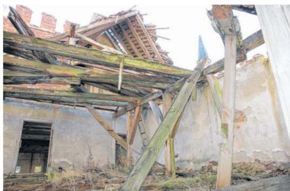
Freier Blick zum Himmel: Über dem Mittelrisalit ist das Dach mittlerweile komplett eingebrochen.
